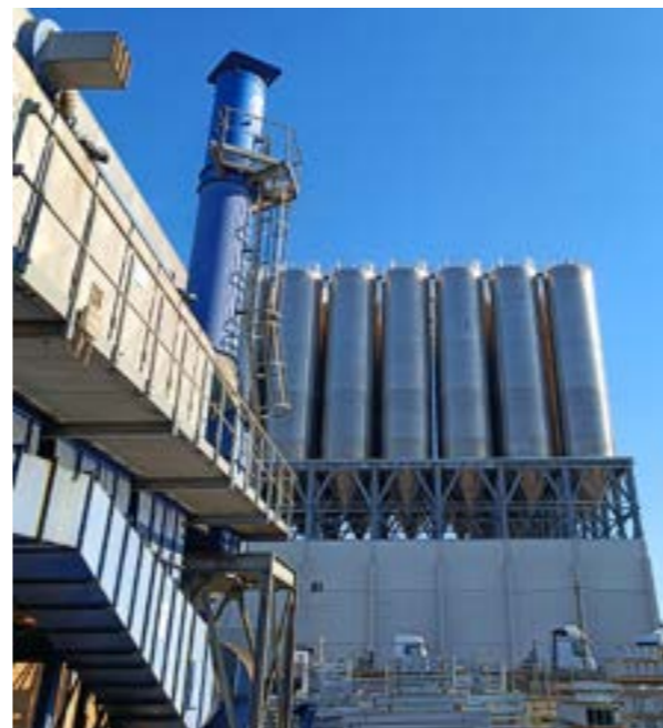
Die Baustelle in Duisburg mit verzinkten Komponenten (Bild Mitte) im Detail.
