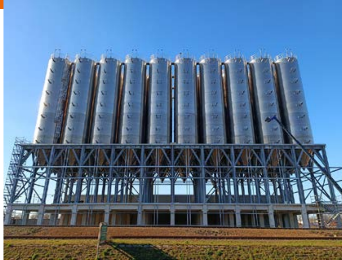
Beindruckende Siloanlage im Aufbau. Am Ende sind es vierzig Silos, die Granulate lagern und weiterverarbeiten können.
